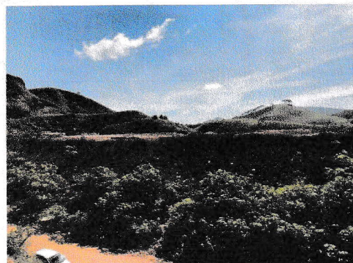
Figura 6: Aterro de Resíduos da Construção Civil do Grama. Fonte: Acervo próprio na época da elaboração do LAS/RAS
