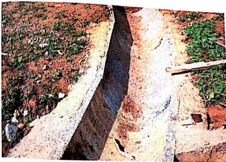
Figura 15 – Calhas do sistema de drenagem do Aterro de Grama. Fonte: Autoria Própria
