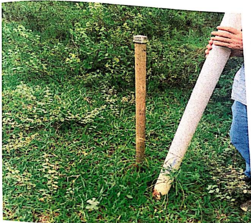
Figura 17 – Poço de monitoramento de águas subterrâneas Aterro de Grama. Fonte: Autoria Própria
