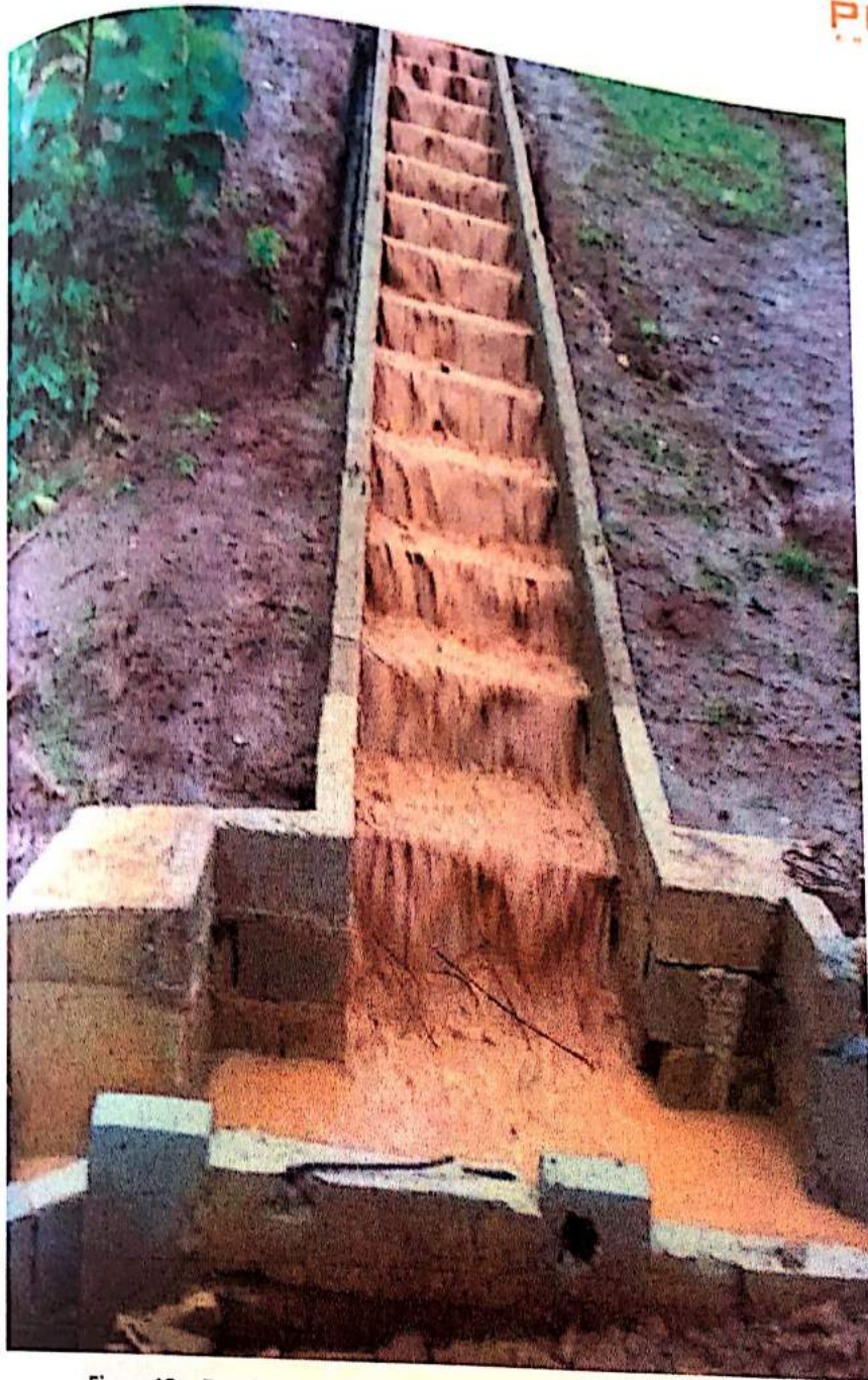
Figura 13 – Escada hidráulica Aterro de Grama. Fonte: Autoria Própria
