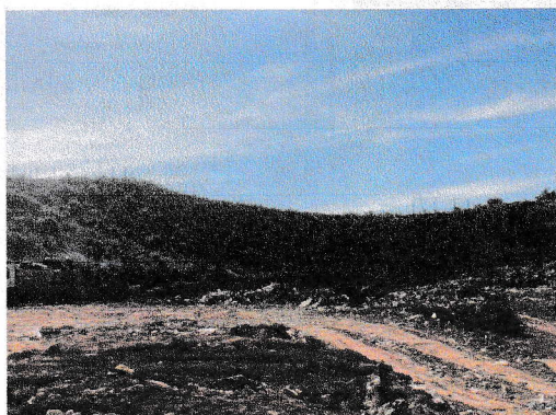
Figura 5: Aterro de Resíduos da Construção Civil do Grama. Fonte: Acervo próprio na época da elaboração do LAS/RAS
